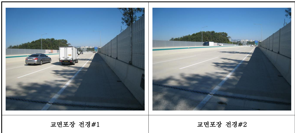
【사진 6.3.19】 교면포장 전경
