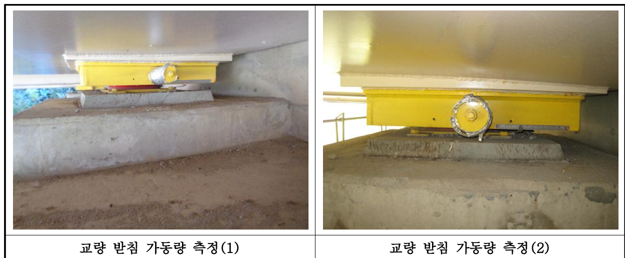
【사진 6.3.15】교량받침 이동량 측정
