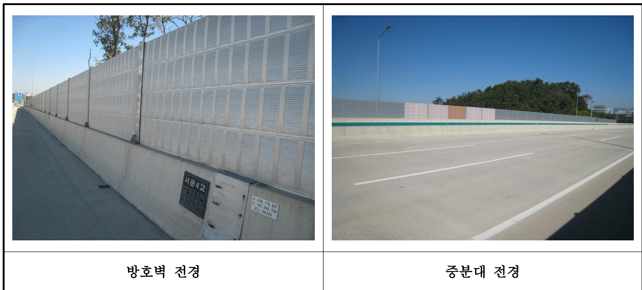
【사진 6.3.23】 방호벽 및 중앙분리대 전경
