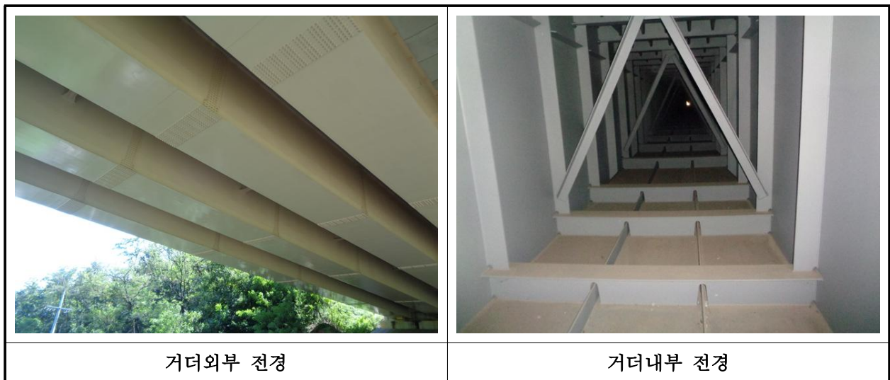
【사진 6.3.4】 거더 전경
