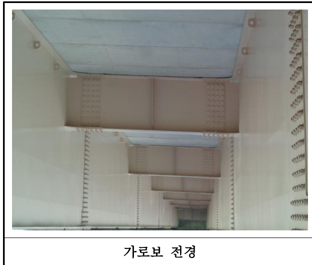
【사진 6.3.6】 가로보 및 세로보 전경
