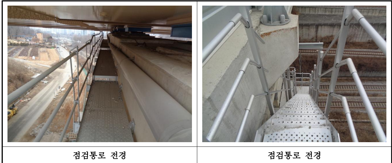
【사진 6.3.25】 교량 점검시설 전경
