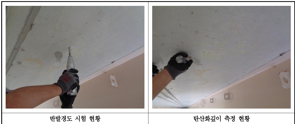
【사진 6.4.1】 콘크리트 내구성조사 현황
