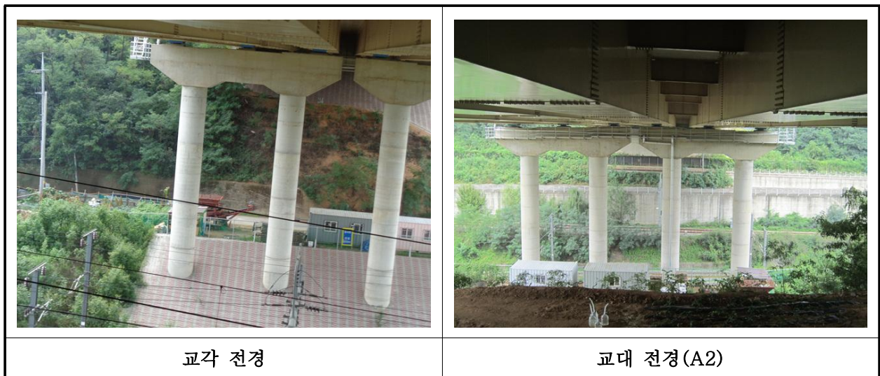
【사진 6.3.10】 교각 전경
