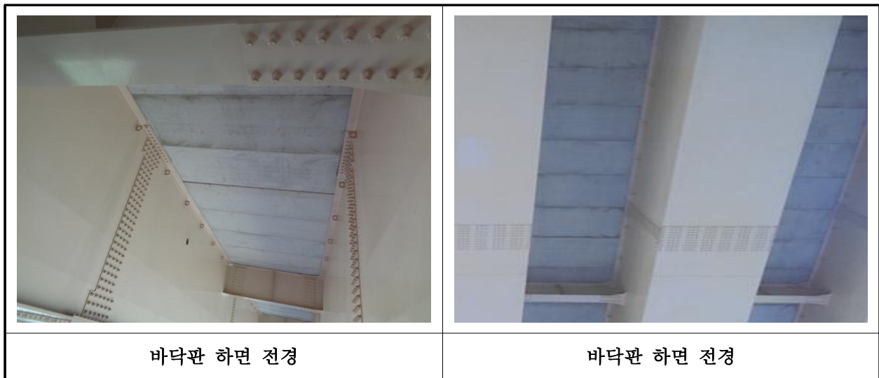
【사진 6.3.2】 바닥판하면 전경
