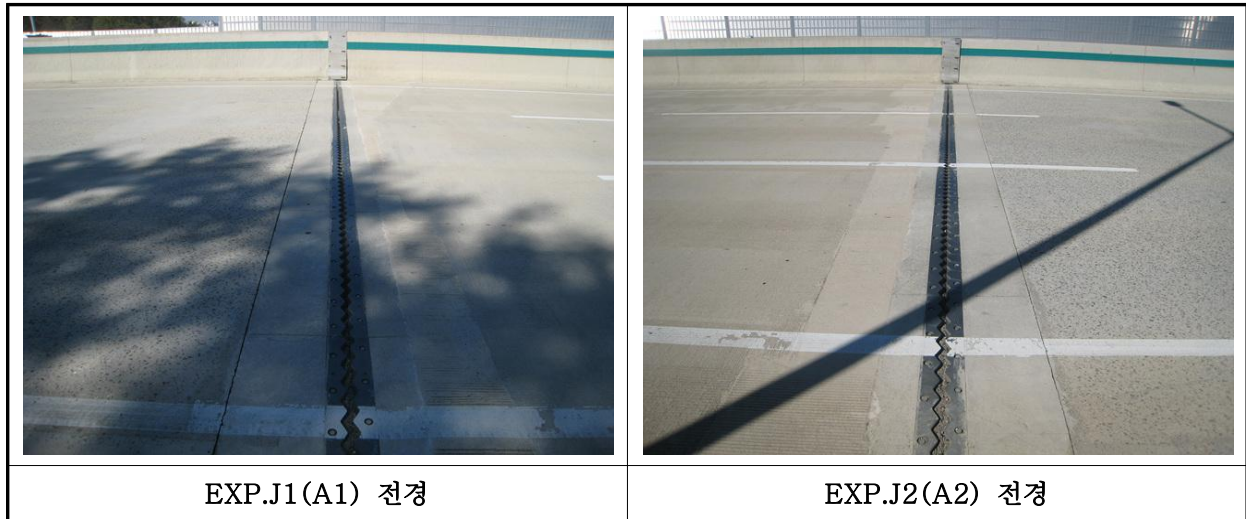
【사진 6.3.16】 신축이음장치 전경
